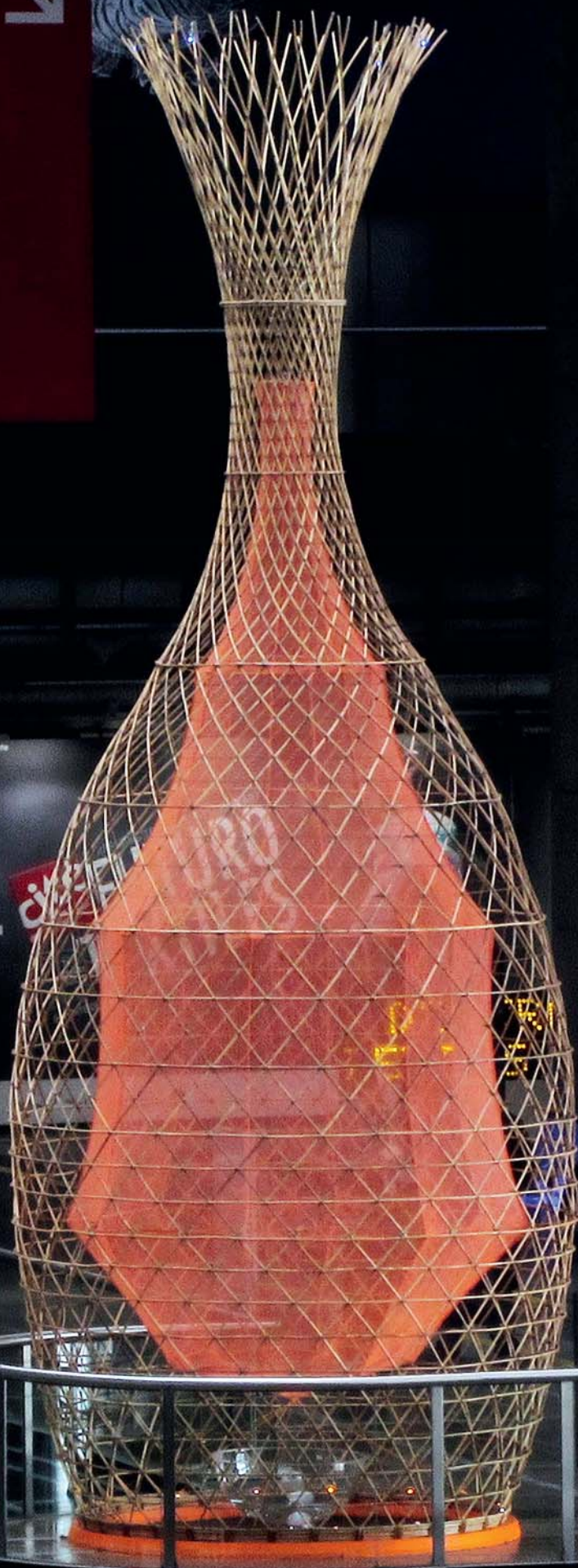
Warkawater: der 9 Meter hohe Bambusturm mit spezieller Textilstruktur erntet Nebel zur Wassergewinnung | Foto: © Architecture and Vision
